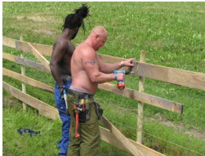
Reparasjon av gjerde i Valdres
