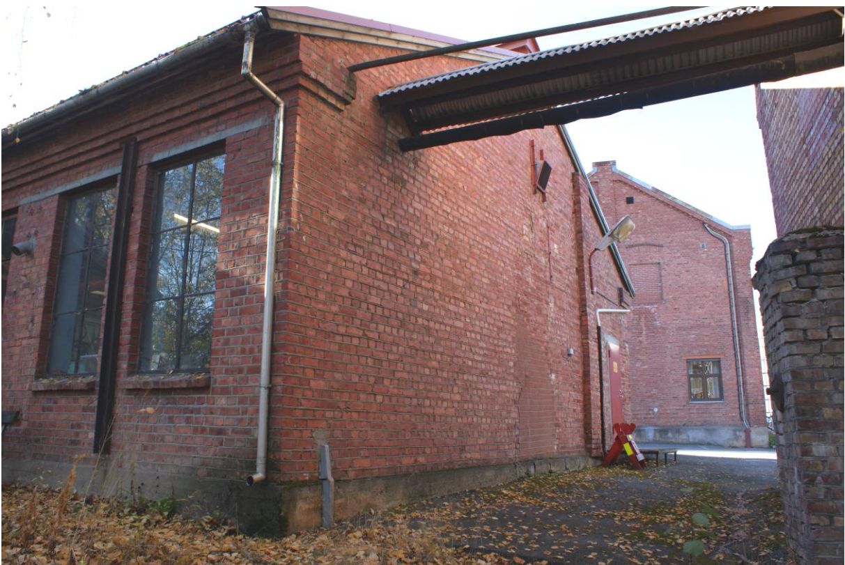
Mot nord, nord/øst
