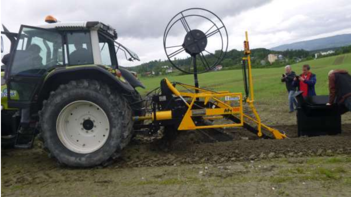
Figur 6. Kjedgegraver i arbeid.
