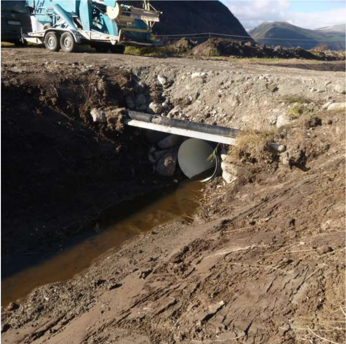
Figur 3. Kulvert i grøft på dyrkamark.
