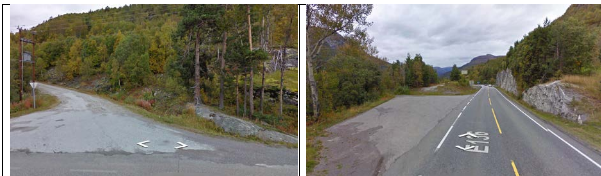
Avkøyrsløse til Øvre Kleiva og gamal vegsløyfe (t.v.) og «stopplomme» ved fylkesgrensa (t.h.).
